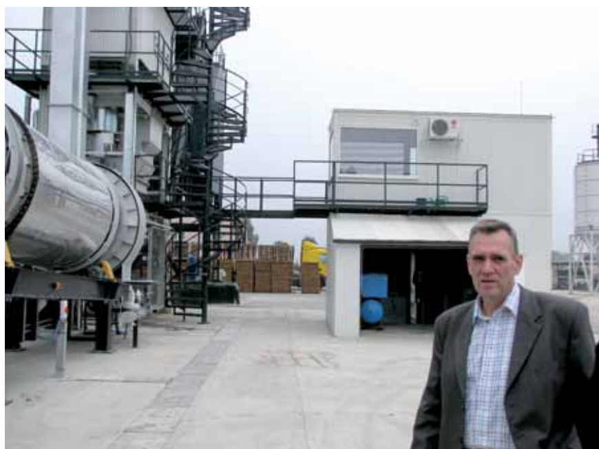
Ważnym elementem firmy jest nowoczesna wytwórnia mas bitumicznych
