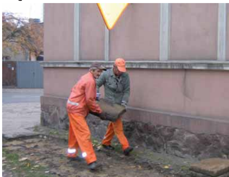
Roboty na Zamkowej rozpoczęły się od usuwania zniszczonych płyt chodnikowych
