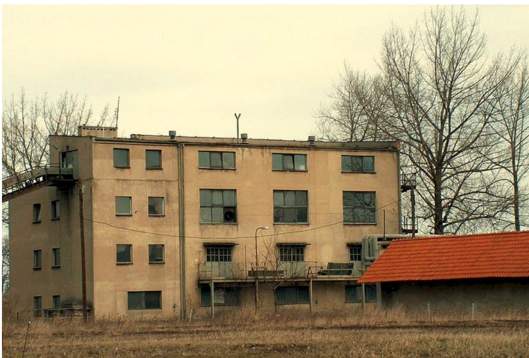
Kotłownia CERABUDU S.A.
