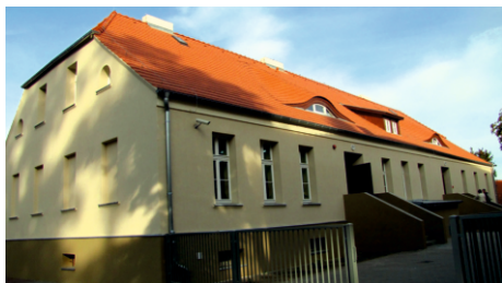
Budynek nr 2 po remoncie – widok od strony dziedzińca szkoły
