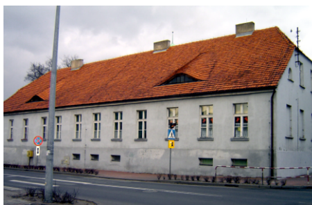
Budynek nr 2 przed remontem
