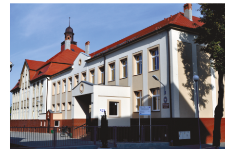
Budynek nr 1 po remoncie – widok od strony dziedzińca szkoły
