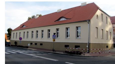
Budynek nr 2 po remoncie –widok od strony ul. Sienkiewicza
