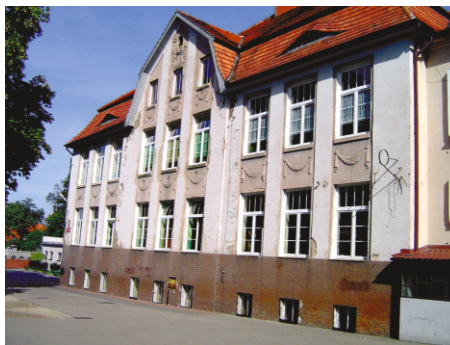
Budynek nr 1 przed remontem
